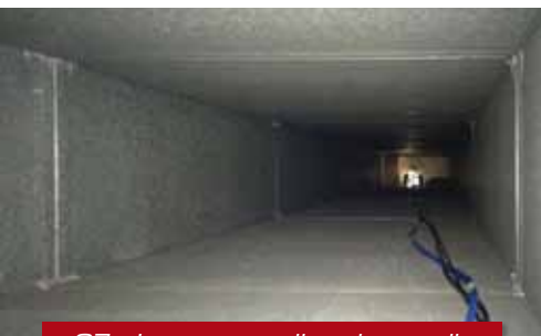
07 - Interno canalizzazione pulita
