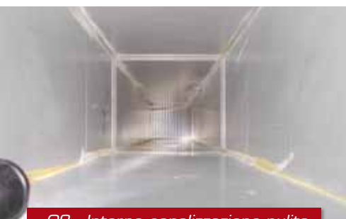
08 - Interno canalizzazione pulita
